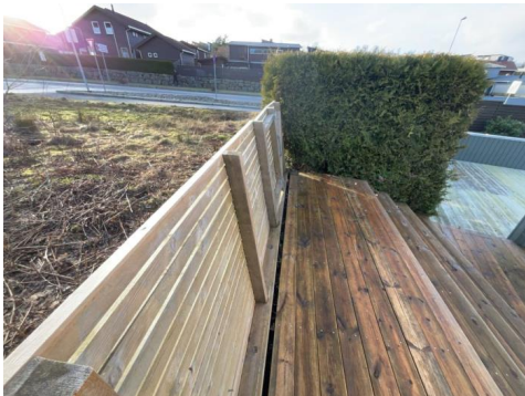
Løst rekkverk/gjerde.
