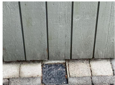
Nedre del av kledning under soveromsvindu.
