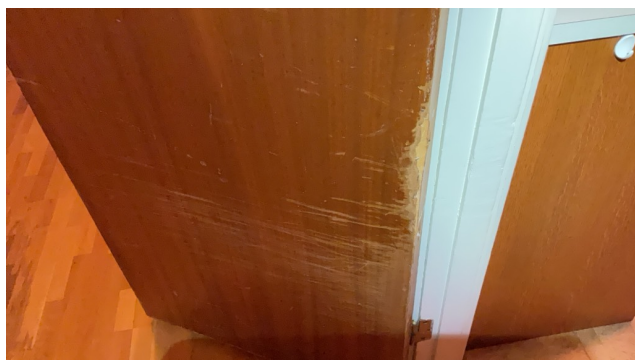
Skader på dører
