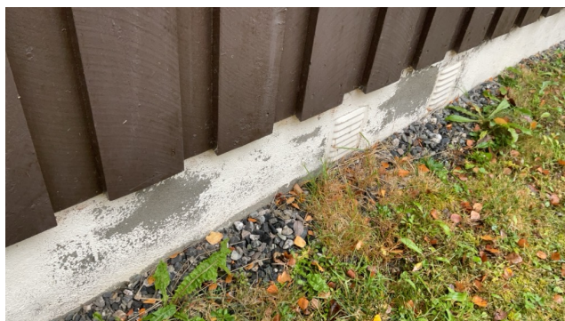
Avflassing av grunnmur
