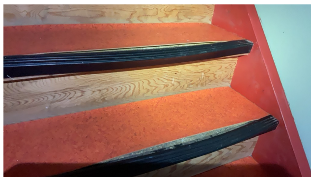
Trapp er slitt der belegget har løsnet
