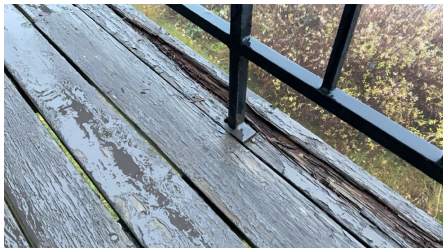
Råteskader
