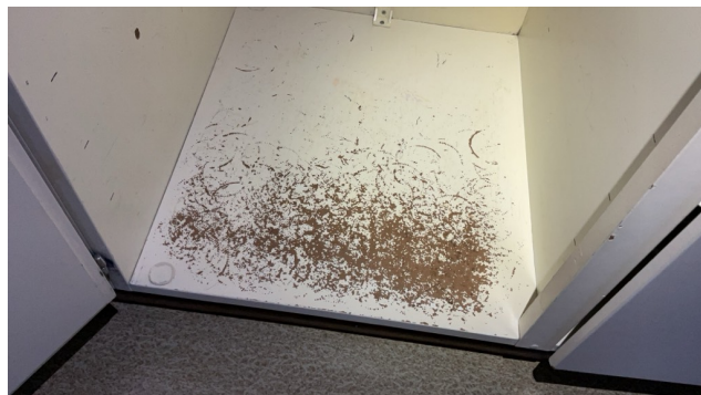
Slitasje i skap
