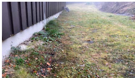
Flatt og manglende terrengfall inntil mur
