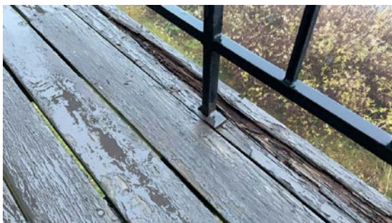
Råteskader
