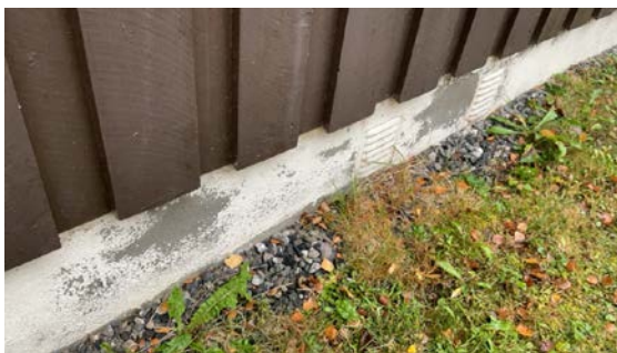
Avflassing av grunnmur
