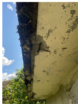
Stedvis råteskader i nedre del av rekkverk
