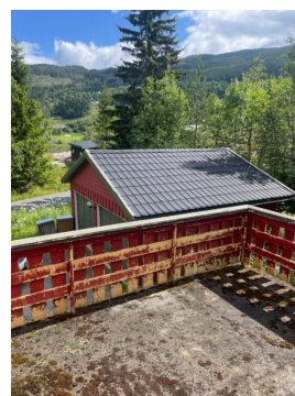
Stedvis råteskader i nedre del av rekkverk
