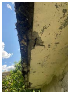
Stedvis råteskader i nedre del av rekkverk
