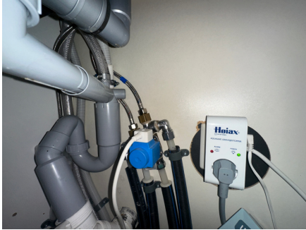
Rørproplegg i kjøkkenbenk med Waterguard
