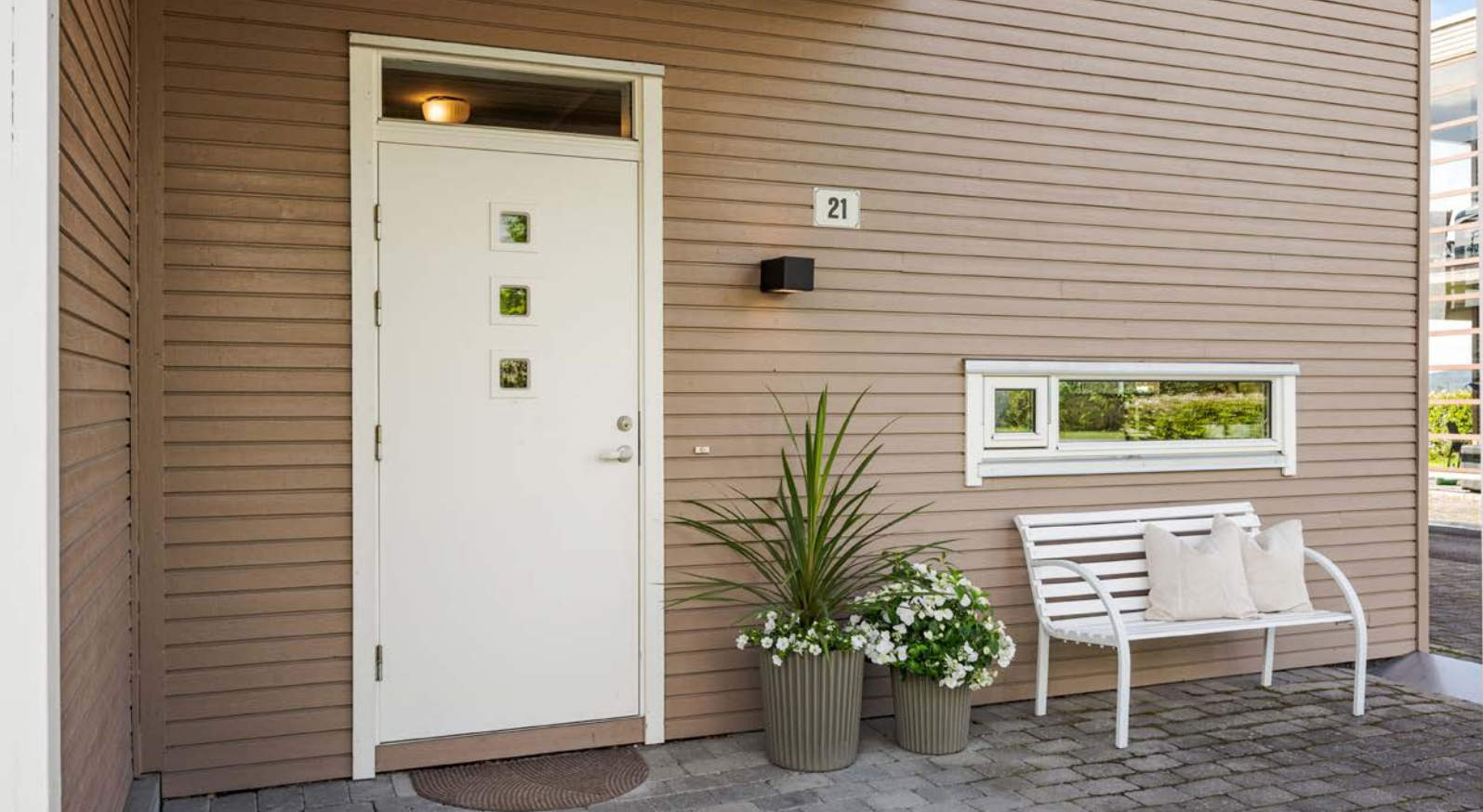
Pent opparbeidet inngangsparti som er delvis overbygd.
