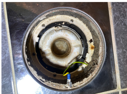
Sluk med synlig banemembran og klemring.
