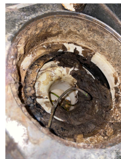
Sluk med synlig banemembran og klemring.
