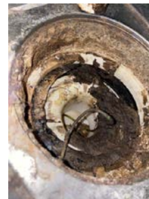
Sluk med synlig banemembran og klemring.
