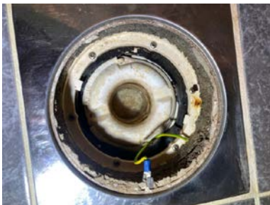
Sluk med synlig banemembran og klemring.
