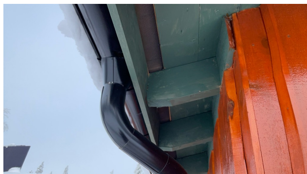
Luftespalte i gesims.
