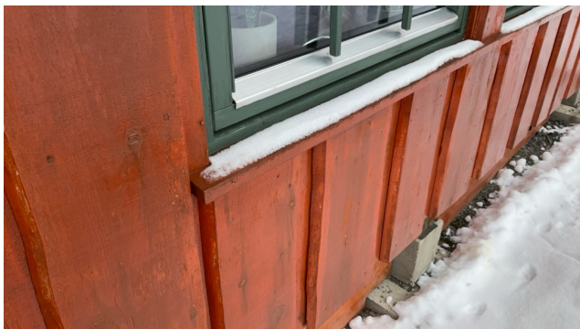
Utvendig løsning med vannbrett av tre
