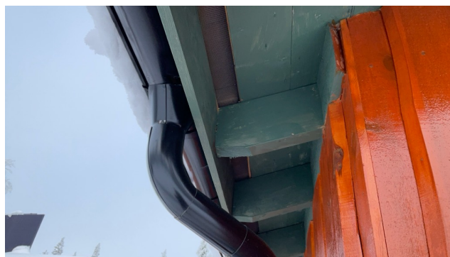
Luftespalte i gesims.
