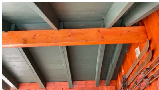
Sperrekonstruksjon ved inngang
