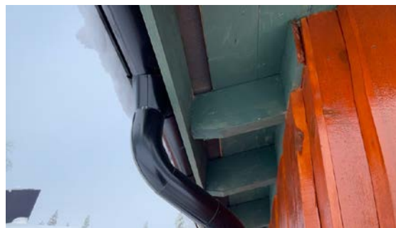
Luftespalte i gesims.
