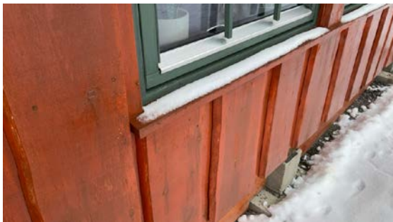
Utvendig løsning med vannbrett av tre
