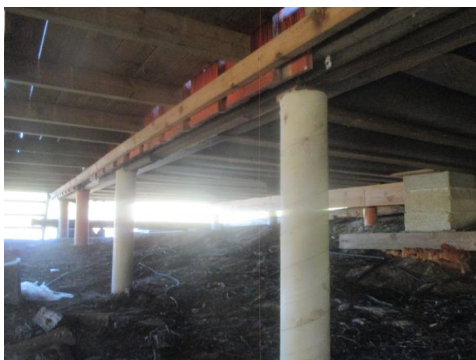
Deler av fundamenteringen.
