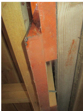
Deler av kledningen med tilhørende belistninger.
