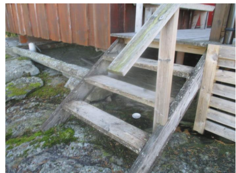
Enkel trapp til terrasse.
