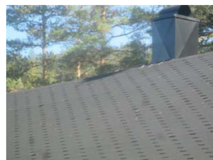
Deler av taktekkingen.
