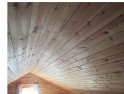
Takkonstruksjonen på hems.
