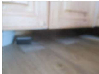
Anbefaler at det blir montert en sokkelfront.
