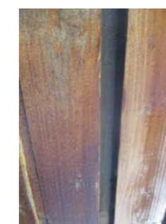
Luftespalter i gesimsen for tilgang på luft til lukket takkonstruksjon.
