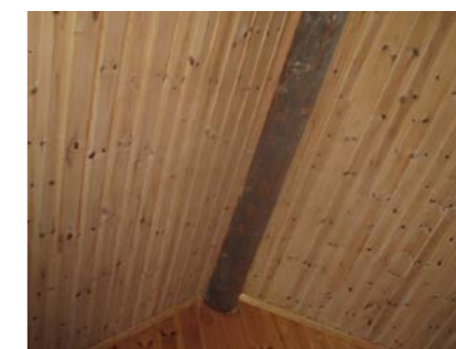
Lukket takkonstruksjon i stue.
