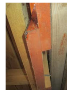
Tilgang på luft bak kledningen.
