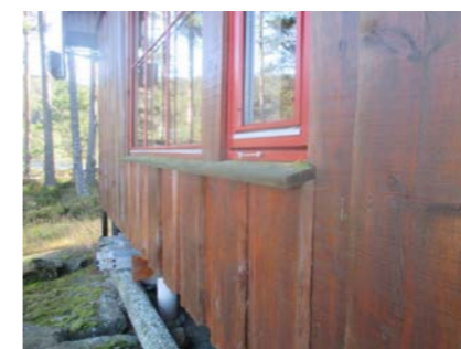
Deler av kledningen med tilhørende belistninger.
