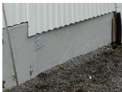
Synlig avtrykk etter utbedring av puss/sprekker i grunnmur
