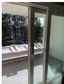
Terrassedør med malt treramme
