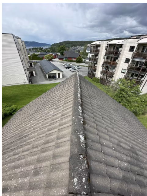
Viser del av taktekingen.
