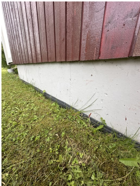
Viser knotteplast med topplis utvendig.
