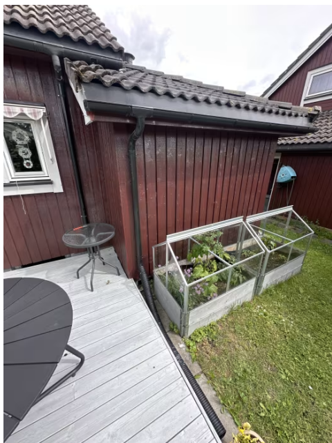
Viser nedløpsrør med etablert drensør.
