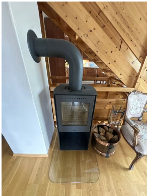
Viser ildsted montert i 1.etasje.
