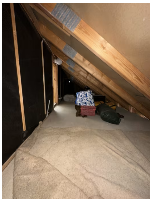
Viser raftekott fra innsiden.
