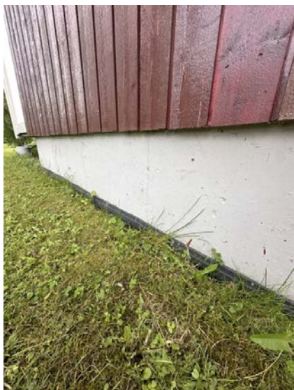
Viser knotteplast med topplist utvendig.
