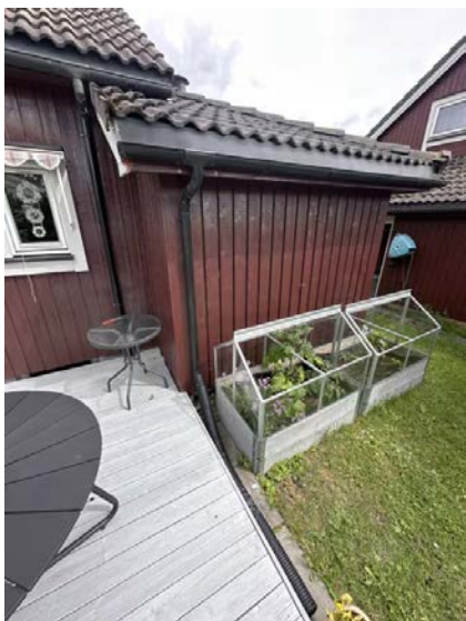
Viser nedløpsrør med etablert drensør.
