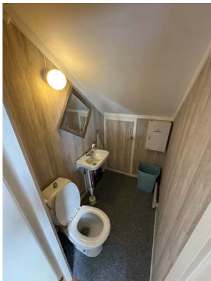
Viser toalettrom i 2.etasje
