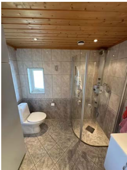
Viser gulvstående toalett, og innfellbare dusjvegger.
