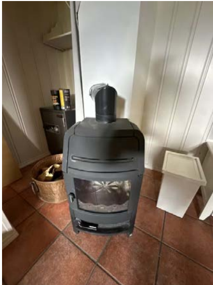
Viser ildsted i kjellerstue.
