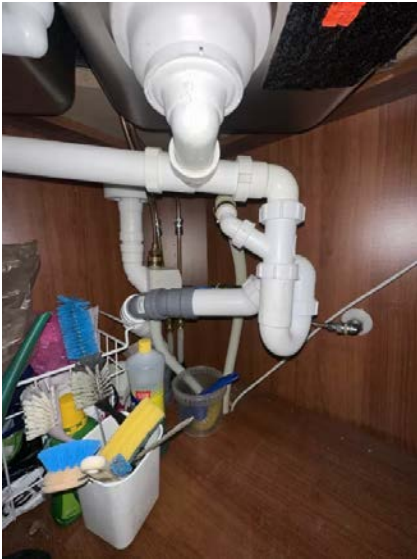
Viser vann og avløpsinstallasjoner under kum.
