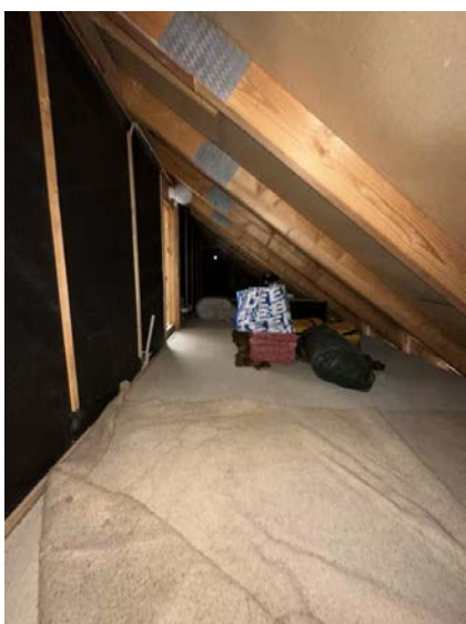
Viser raftekott fra innsiden.
