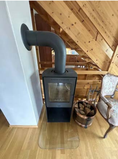
Viser ildsted monteret i 1.etasje.
