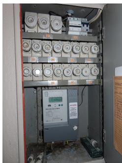
Eldre skrusikringer/porselenssikringer.
