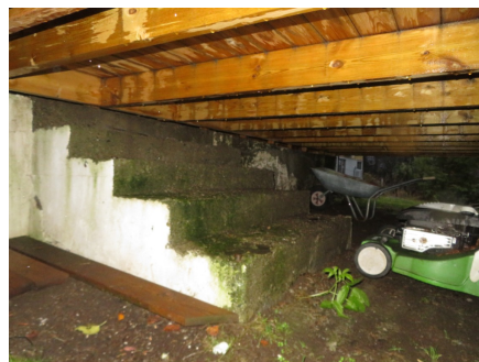
Del inn mot boligen er etablert til eksisterende konstruksjoner - tidligere betongtrapp som var etablert ut for terrassedøren til terreng.
