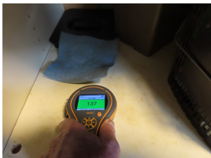
Fuktsøk i benkeskap - ingen påviste forhøyede fuktverdier.
