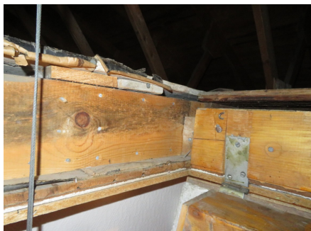
Nærbilde av oppbygging, hvor det ses faspanel med underliggende plate i himlinger.
