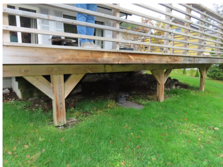
Punktfundamenter til terreng med bærende betonghelle.
