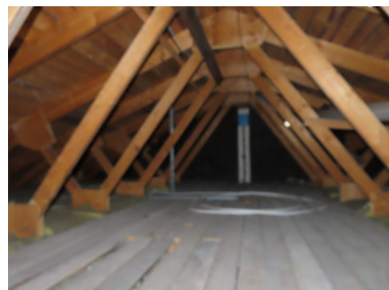
Plassbygde, selvbærende W-takstolkonstruksjoner
