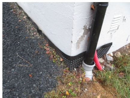
Drenert etter øvre langside - platonplast ses ført opp over terreng.
