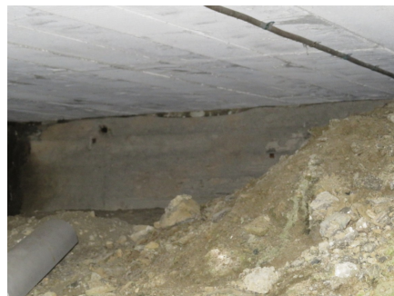
Betongmur og ytongdekke.
