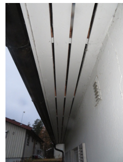
Spaltegesims (Uten fluenetting).
