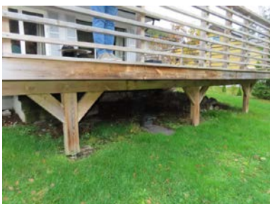
Punktfundamenter til terreng med bærende betonghelle.
