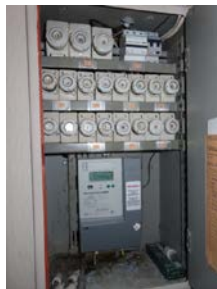
Eldre skrusikringer/porselenssikringer.
