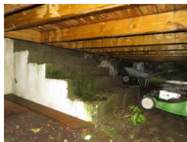
Del inn mot boligen er etablert til eksisterende konstruksjoner - tidligere betongtrapp som var etablert ut for terrassedøren til terreng.
