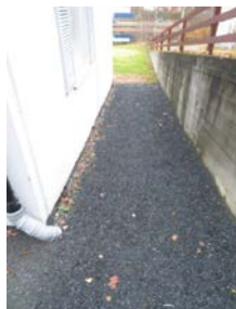
Drenert etter øvre langside - platonplast ses ført opp over terreng.
