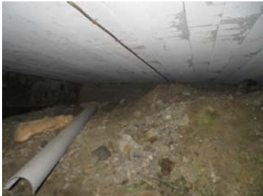
Bilde fra krypkjeller, hvor det ses ytongdekke som underlag for påstøp. Ingen påviste skader/avvik ved visuell besiktigelse.
