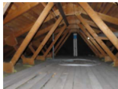
Plassbygde, selvberende W-takstolkonstruksjoner
