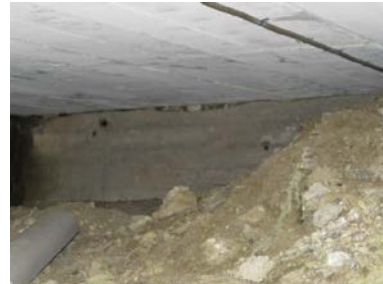
Betongmur og ytongdekke.
