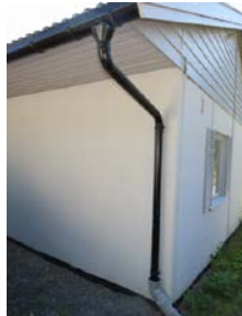
Nedløpsrør ført til nedgravde rør som er ført vekk fra vegglivet.
