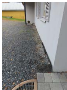
Drenert etter øvre langside - platonplast ses ført opp over terreng.
