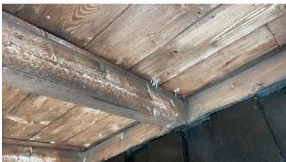
Spikergjennomslag ved inngangsparti
