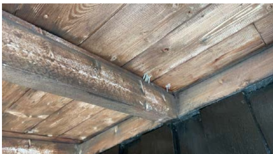
Spikergjennomslag ved inngangsparti
