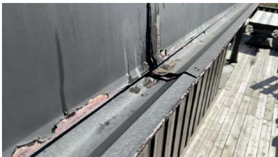
Rust på beslag i renner med utettheter i skjøter
