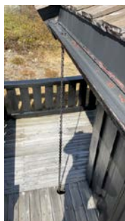
Rust på beslag i renner med utettheter i skjøter
