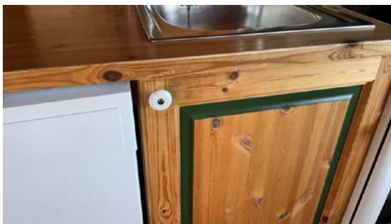
Normal brukslitasje på innredning
