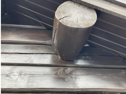
Takåsgjennomføring i laftet vegg
