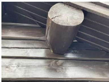
Takåsgjennomføring i laftet vegg
