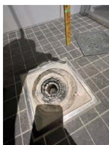
Membran klemt under slukring
