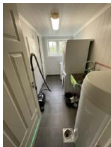
Vegg over skyllekum med malte mdf-plater
