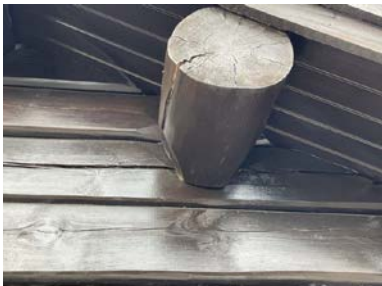
Takåsgjennomføring i laftet vegg
