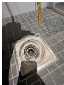
Membran klemt under slukring
