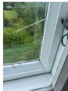
Vinduer er slitt og har oppnådd forventet levetid
