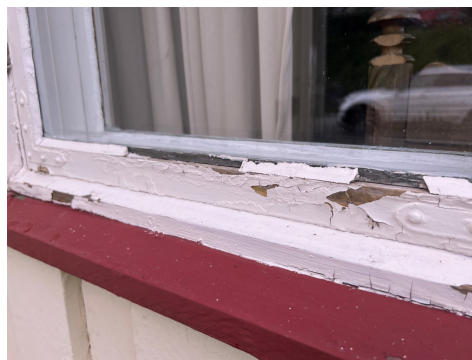
Vinduer er slitt og har oppnådd forventet levetid
