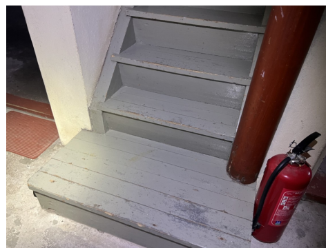
Slitasje på kjellertrapp
