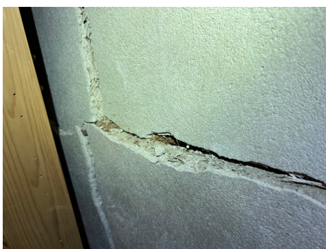
Sprekker/utgliding av mur mot østlig retning, jmf eier foretatt lokale tiltak utvendig
