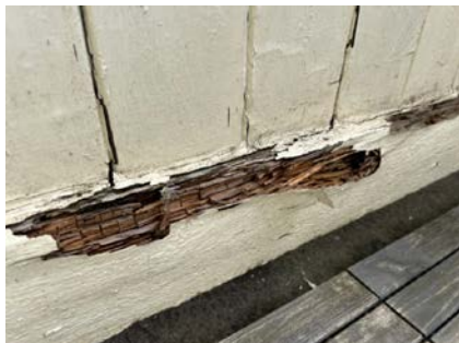
Råte i rekkverkskonstruksjon på terrasse mot vestlig retning
