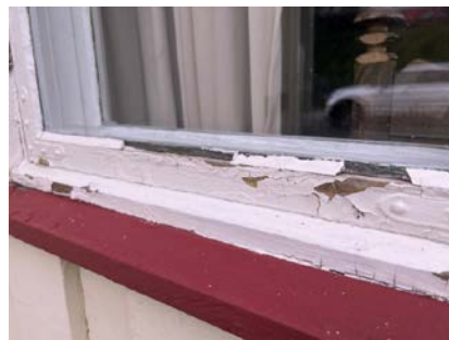
Vinduer er slitt og har oppnådd forventet levetid
