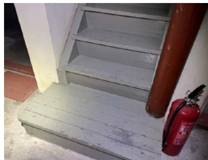
Slitasje på kjellertrapp
