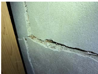
Sprekker/utgliding av mur mot østlig retning, jmf eier foretatt lokale tiltak utvendig
