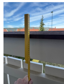
Bildet viser høyden på rekkverket på verandaen.
