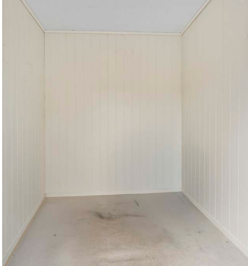
Utvendig bod som er nede ved trappeoppgang.
