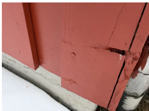
Fuktskadet kledning.
