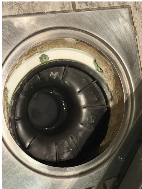
Plastsluk med spor etter membran.
