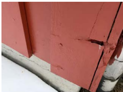
Fuktskadet kledning.
