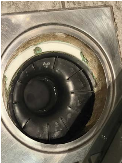
Plastsluk med spor etter membran.
