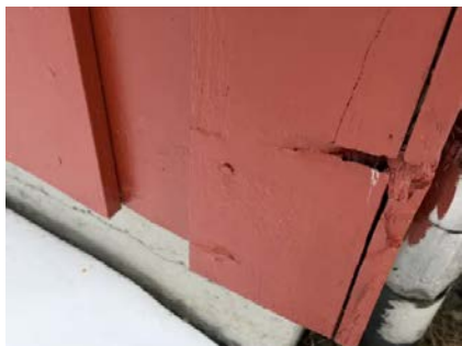
Fuktskadet kledning.
