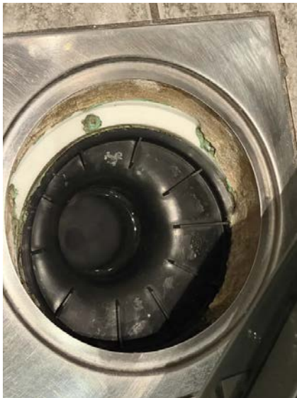
Plastsluk med spor etter membran.
