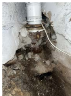
Overgang mellom støpejern og plast.
