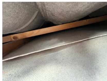
Undertak av plater/bord med undertakspapp, lekter og sløyfer.
