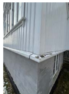
Avflasset maling på vannbrett.
