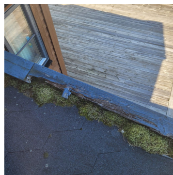
Takhette flasse av overflatebehandling
