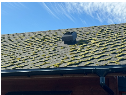
Shingel takteking. En del mose på tekkingen.
