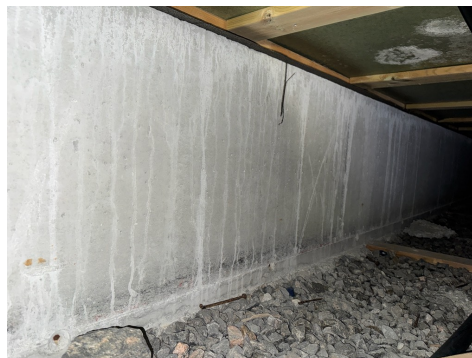
Lav betonggrunnmur
