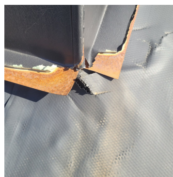
Takhette flasse av overflatebehandling
