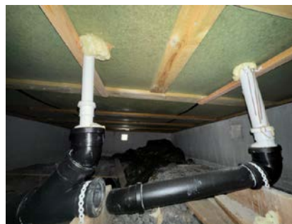
Avløpsrør i plast.
