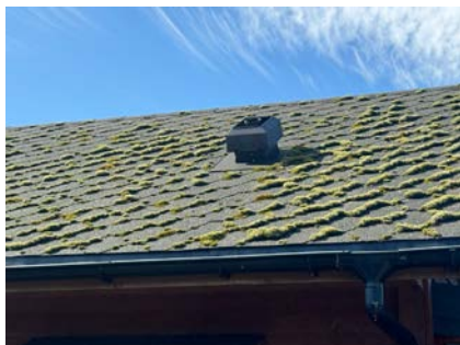
Shingel takteking. En del mose på tekkingen.
