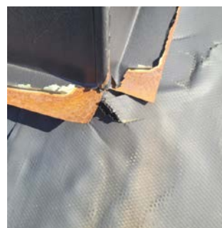
Takhette flasse av overflatebehandling
