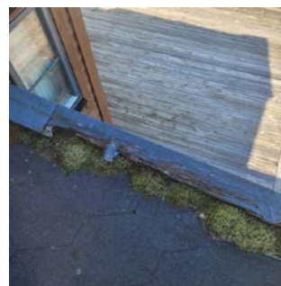
Takhette flasse av overflatebehandling
