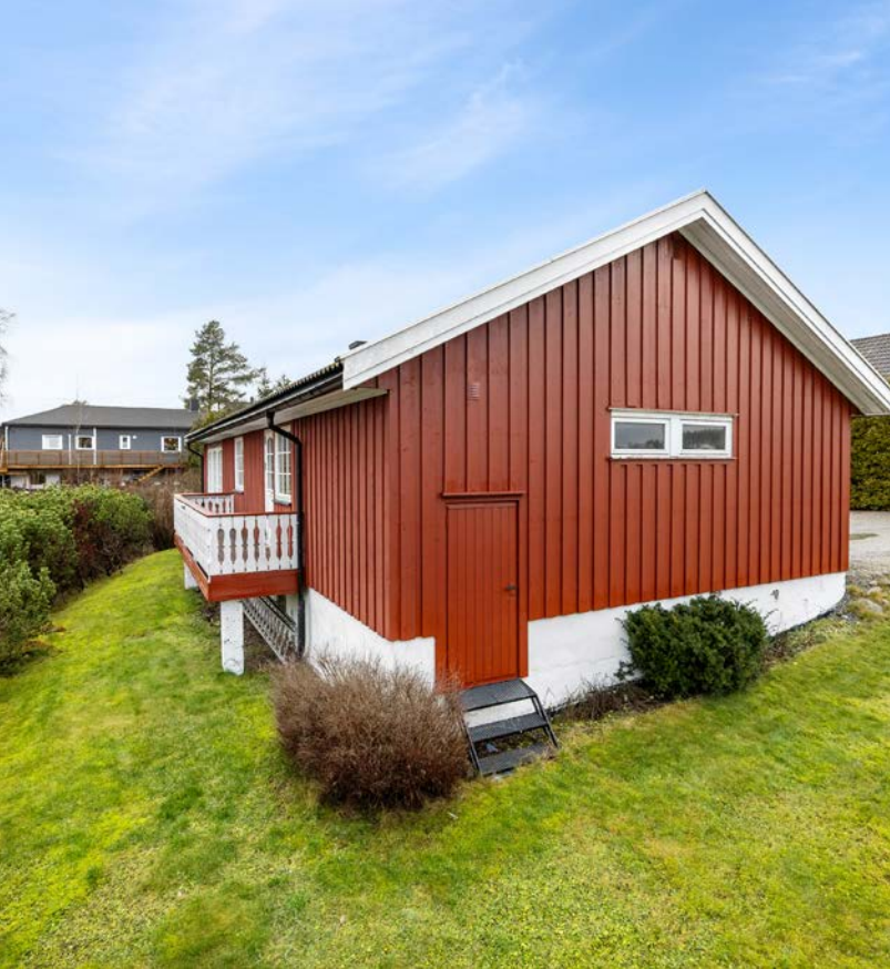
I bakkant av garasjen er det utvendig adkomst til en bod under garasjen.
