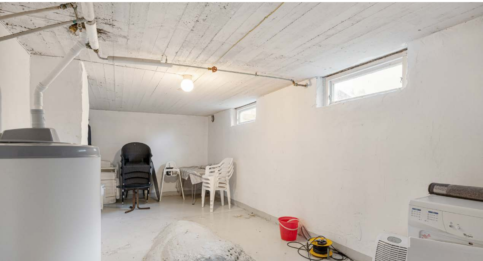
Vaskerommet har utslagsvask og opplegg for vaskemaskin.
