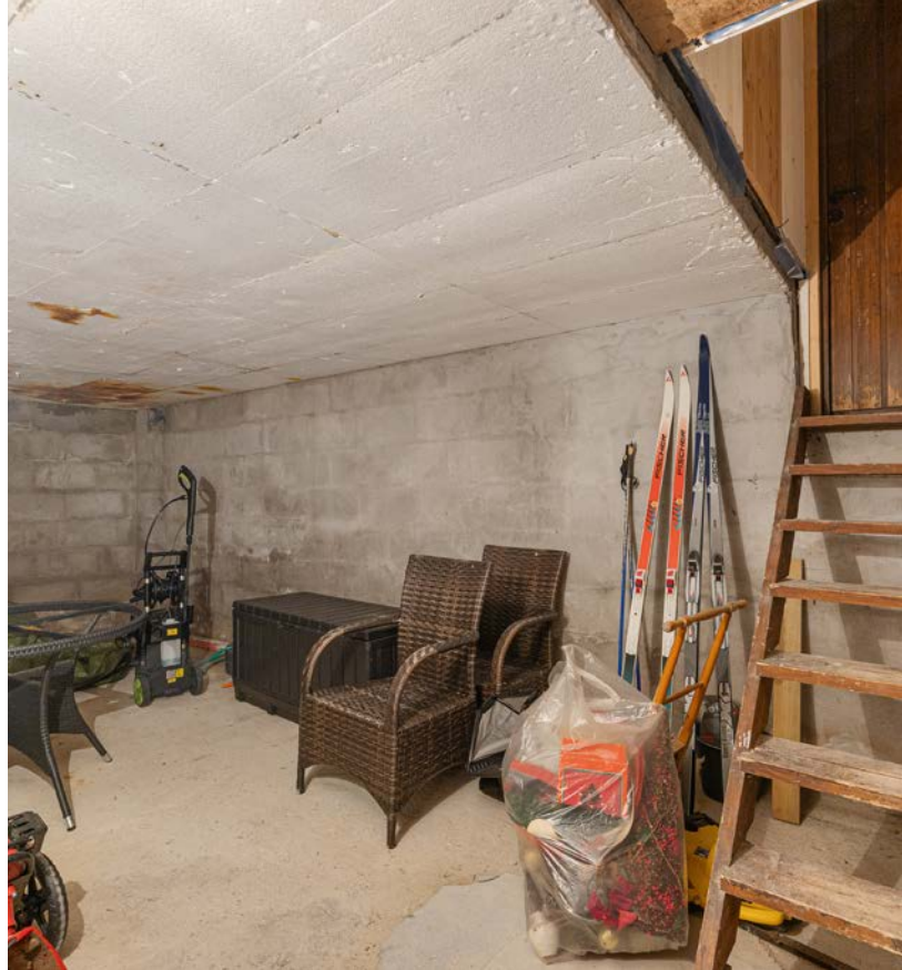
Fra boden under garasjen er det videre adkomst til kjelleretasjen.
