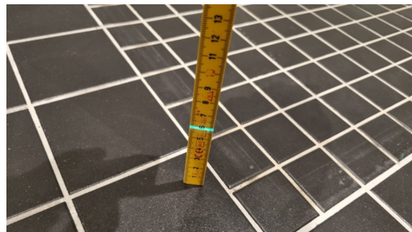
Gulvet har fall mot dusjsone.
