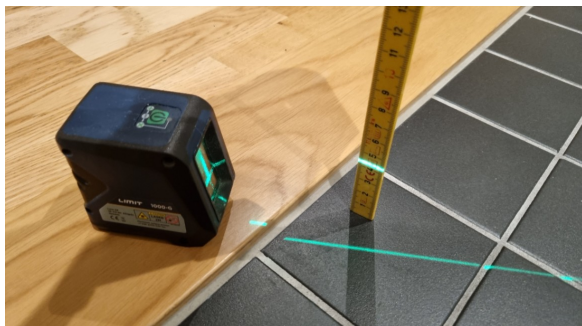
Kontroll av fall.
