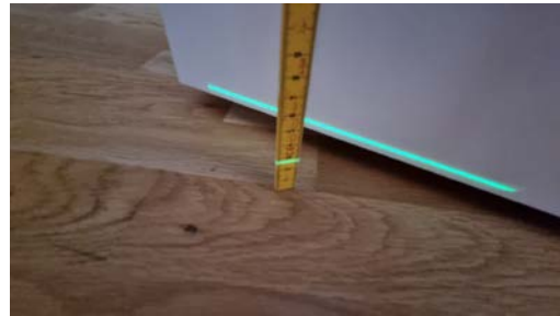
Kontroll av planavvik.
