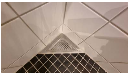
Kontroll av sluk.
