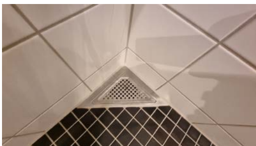
Kontroll av sluk.
