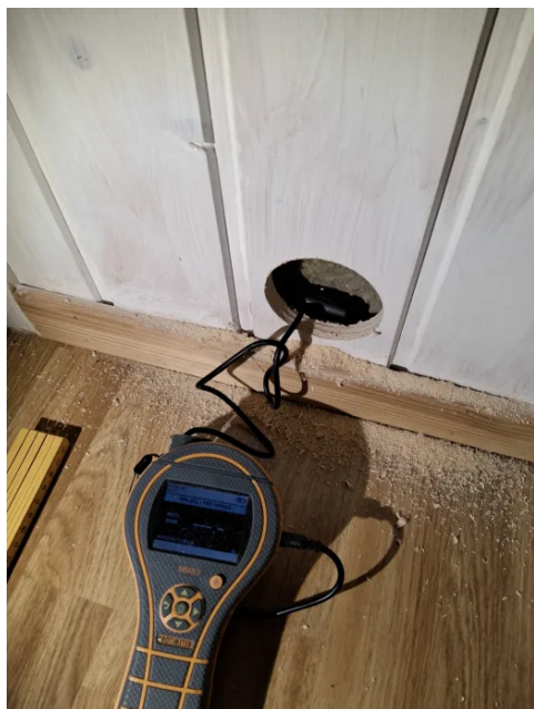
Bilde fra fuktmåling i veggkonstruksjon tilstøtende våtrom.
