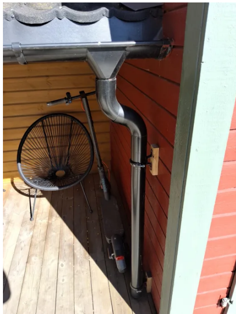
Takrenner og nedløpsrør av metall på takoverbygg og bod på terrasse.
