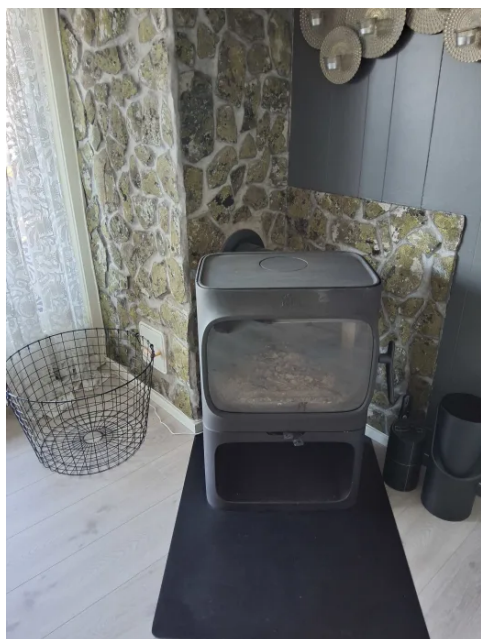
Vedovne med glassdør i stue.
