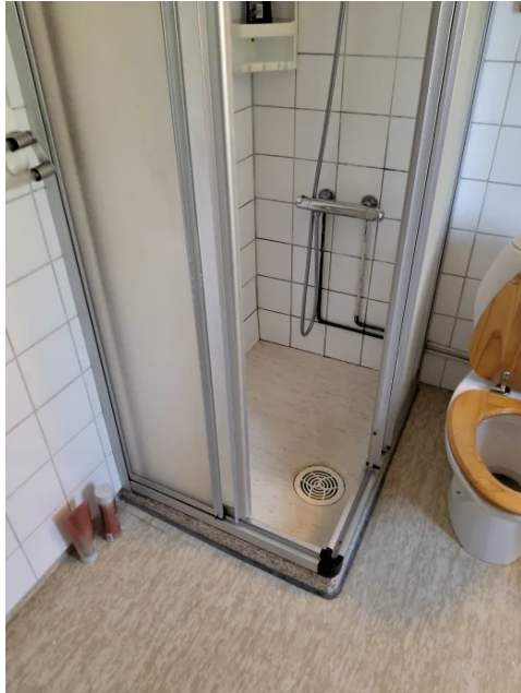
Sluk er isolert i dusjsonen.
