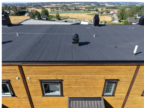
Det er etablert flere sluk på takflaten.
