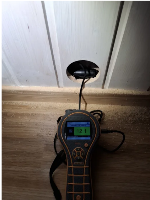
Bilde fra fuktmåling i utlektet veggkonstruksjon.
