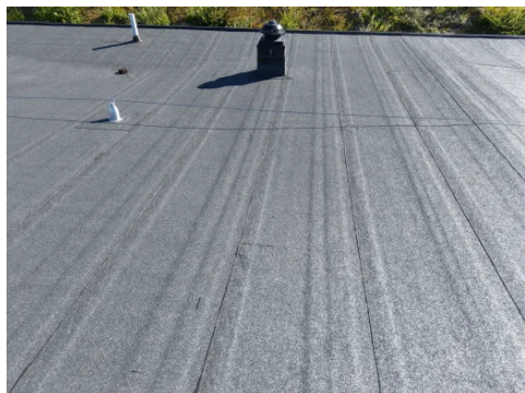
Taket er tekket med asfaltpapp.
