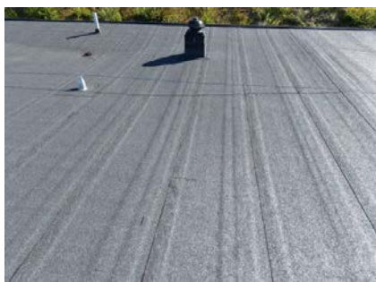
Taket er tekket med asfaltpapp.
