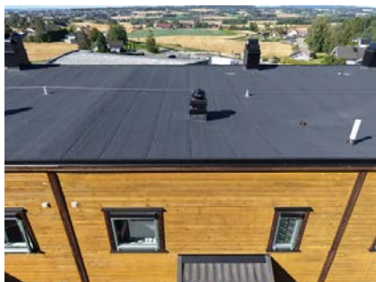
Det er etablert flere sluk på takflaten.
