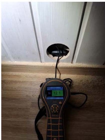
Bilde fra fuktmåling i utlektet veggkonstruksjon.
