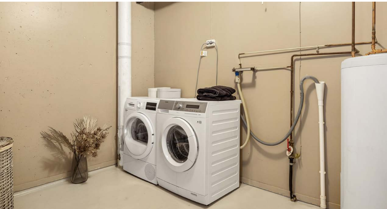
Vaskerom i kjeller med opplegg for vaskemaskin og tørketrommel.
