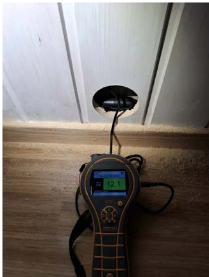
Bilde fra fuktmåling i utlektet veggkonstruksjon.
