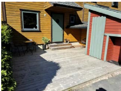
Oversiktsbilde terrasse med bod.
