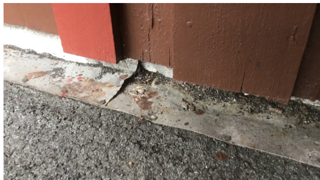
Utettheter i dekke over inngang
