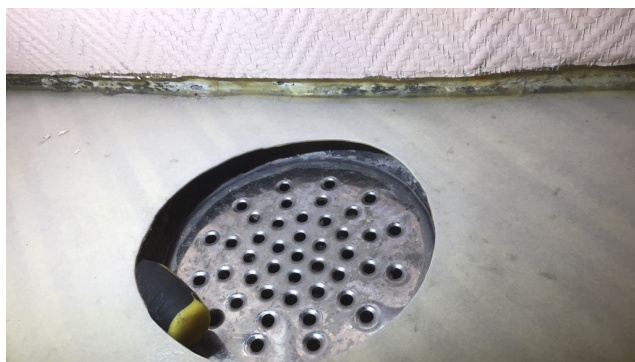
Løst belegg rundt sluk, fuktskader i nedkant veggplater
