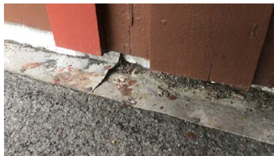
Utteitheter i dekke over inngang
