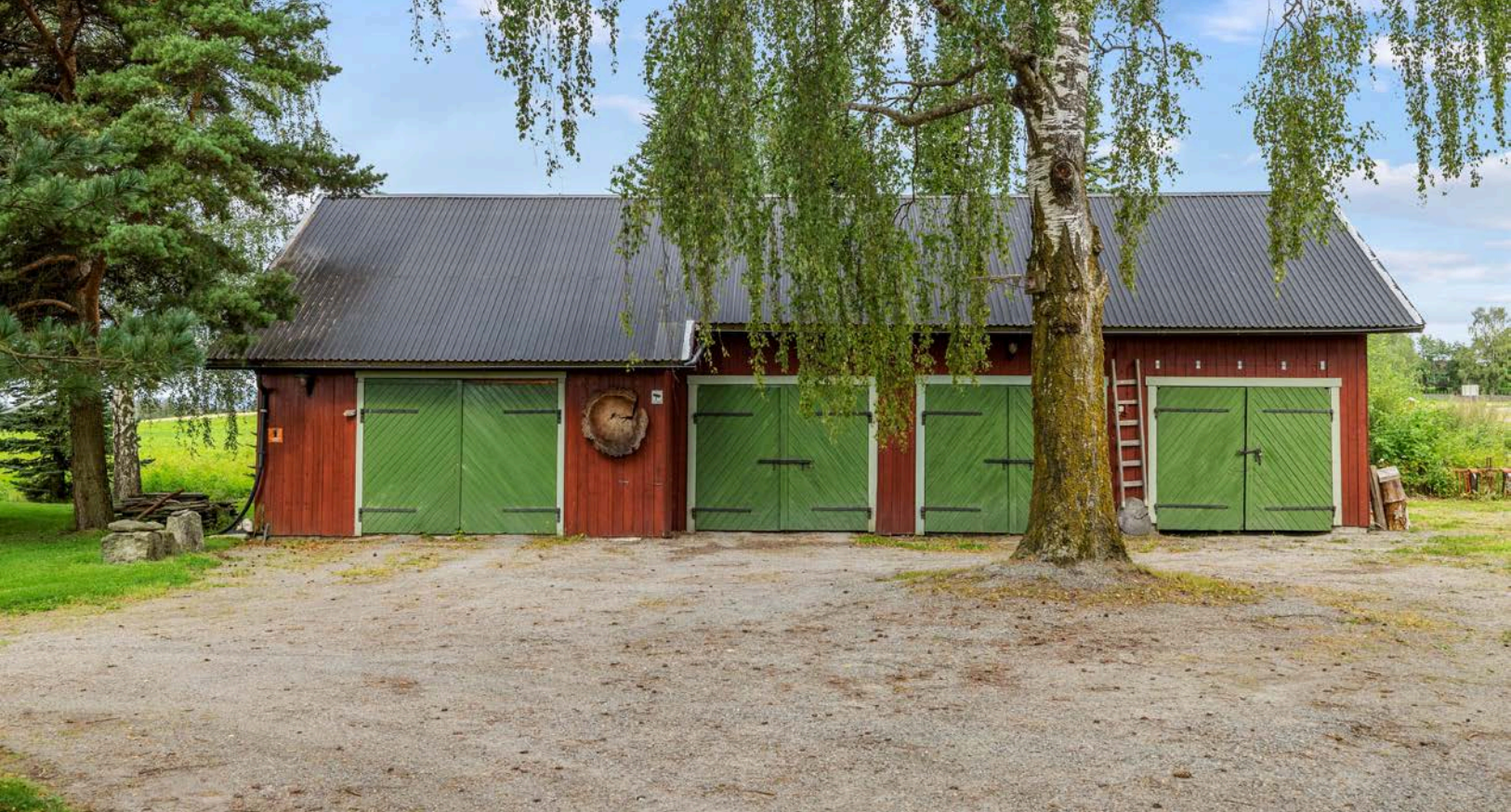
Eldre garasjebygg med fire garasjeplasser.
