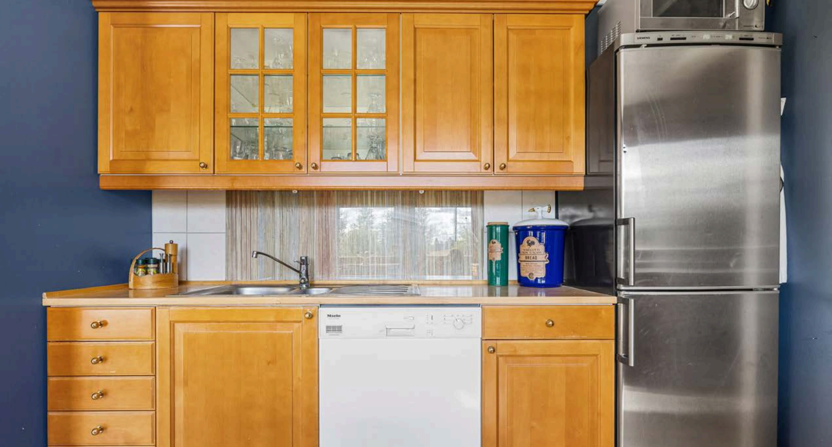
Laminerte benkeplater med oppvaskkum med skyllekum i rustfritt stål. Det er fliser og glassplate i benkeryggen.
