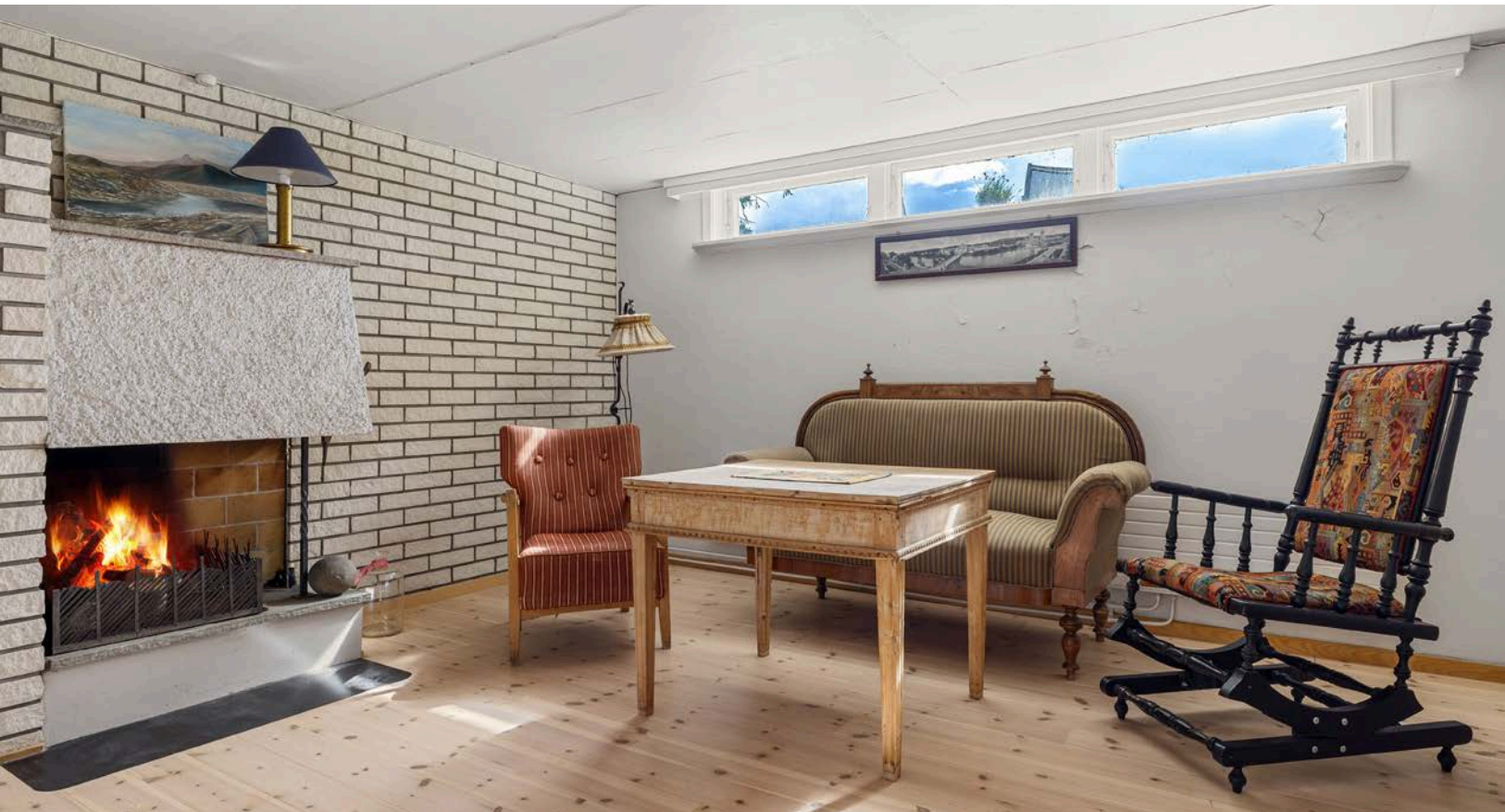
Rom i kjeller som er innredet og brukt som kjellerstue. Rommet har for små vinduer til at disse er godkjente som rømningsveier. Rommet er derfor ikke godkjent til varig opphold.
