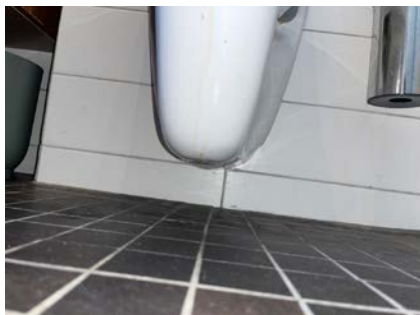
Ingen spalte wc.
