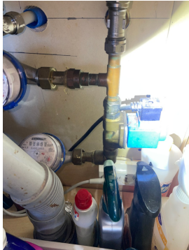
Stoppekran og vannmåler på kjøkken
