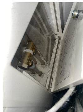
Fordelerskap for vannrør i vegg på bad.
